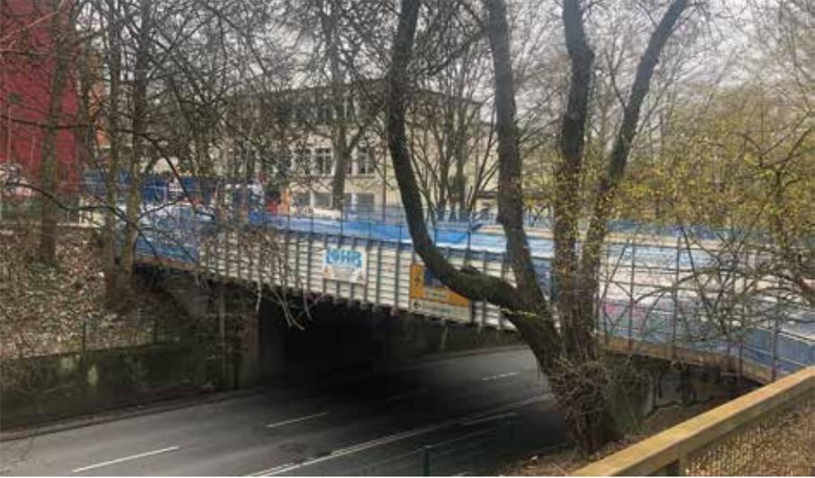
Die Abbrucharbeiten sind abgeschlossen worden. Die planmäßig entnommenen Proben vor dem Wiederaufbau der Brücke haben erhöhte Chloridwerte der tragenden Betonplatte aufgezeigt. Es werden jetzt weitere Proben entnommen, vom Gutachter bewertet und die Grundlage für die weitere Sanierung geschaffen.
